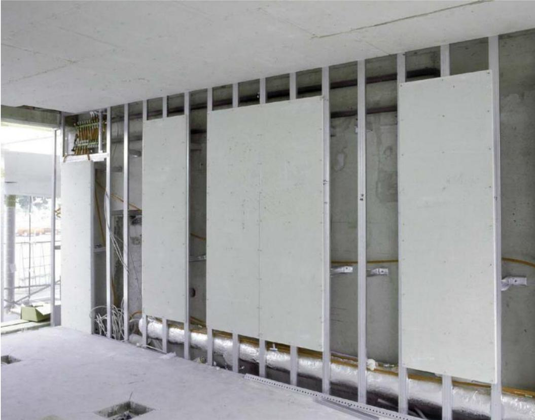
Deckenheizung-/Kühlung in Trockenbauweise
